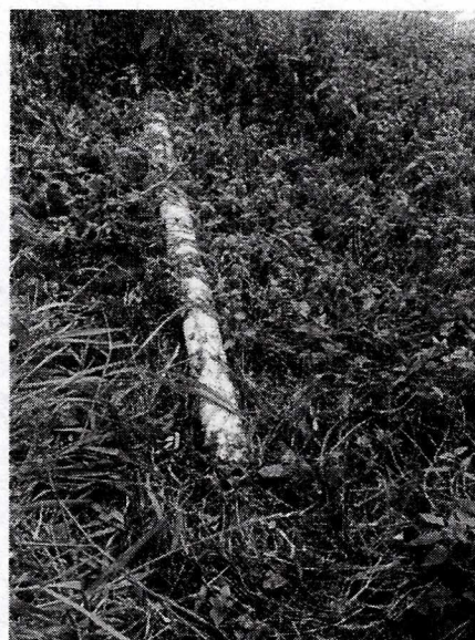
Fotografía 9 Salida del vertimiento en tubería 4" hasta Embalse La Esmeralda de Chivor.
