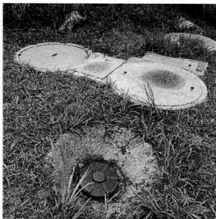
Fotografía 6 Cajas de inspección y tanque séptico integrado.
